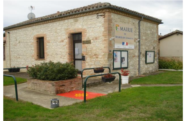
Sécurisation de la mairie par la pose de grilles extérieures.
